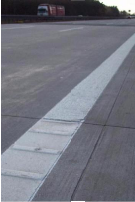
Marcaje de borde de paso con perfilado KP/ aglomerados KP en la autopista A 2 de día, dirección autopista Hannover, km 5,0
