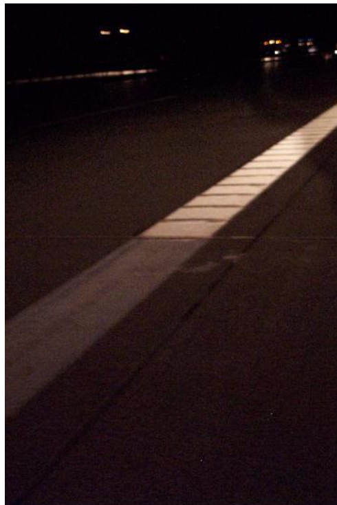
Marcaje de borde de paso KP aglomerado / KP 90° perfilado transversal en la A 2 de noche, Dirección Hannover, km 15,3
