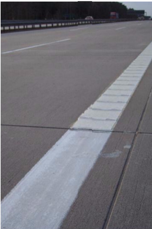
Marcaje de borde de paso KP aglomerado / KP 90° perfilado transversal en la A 2 de día, Dirección Hannover, km 15,3
