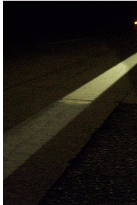
Marcaje de borde de paso con pintura/ aglomerado KP en la A 2 de noche, Autopista dirección Hannover, km 12,5
