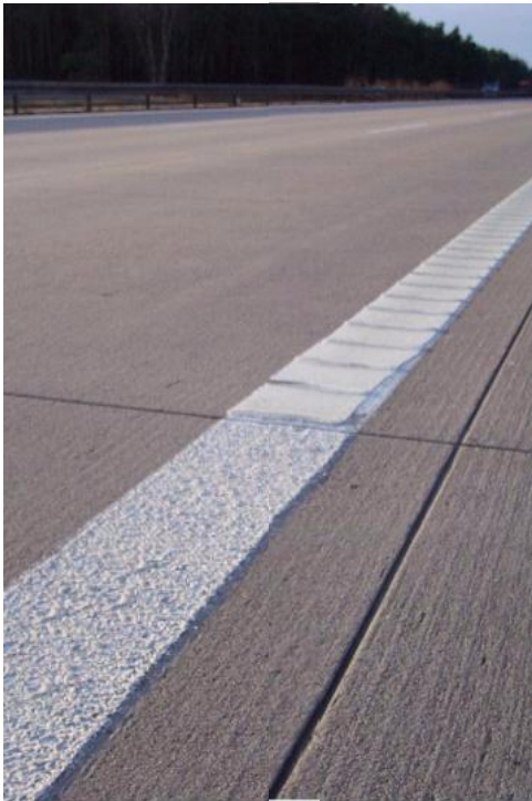
Marcaje de borde de paso KP aglomerado / KP 90° perfilado transversal en la A 2 de día, Dirección Hannover, km 13,5
