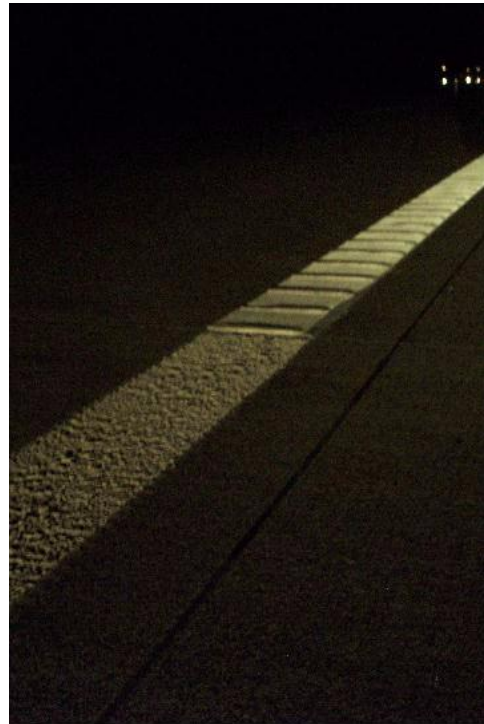
Marcaje de borde de paso KP aglomerado / KP 90° perfilado transversal en la A 2 de noche, Dirección Hannover, km 13,5
