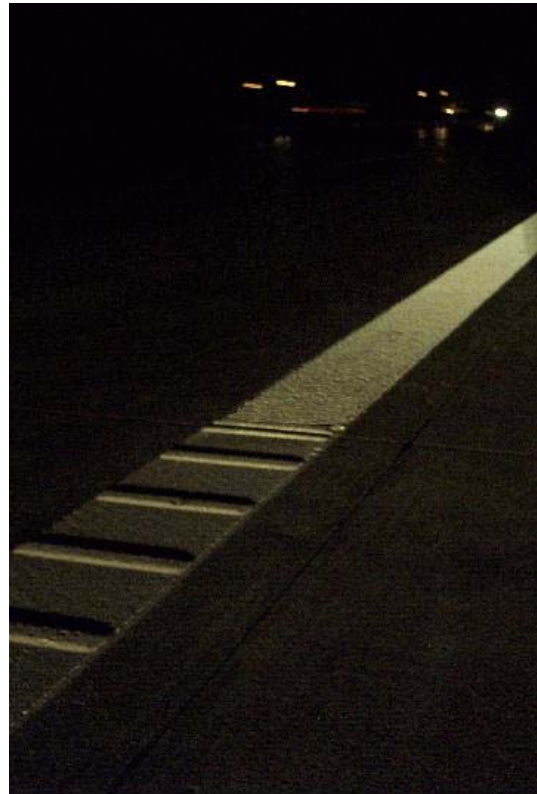
Übergang Randmarkierung KP profiliert/ KP Agglomerate auf der BAB A 2 bei Nacht, Richtungsfahrbahn Hannover, km 5,0
