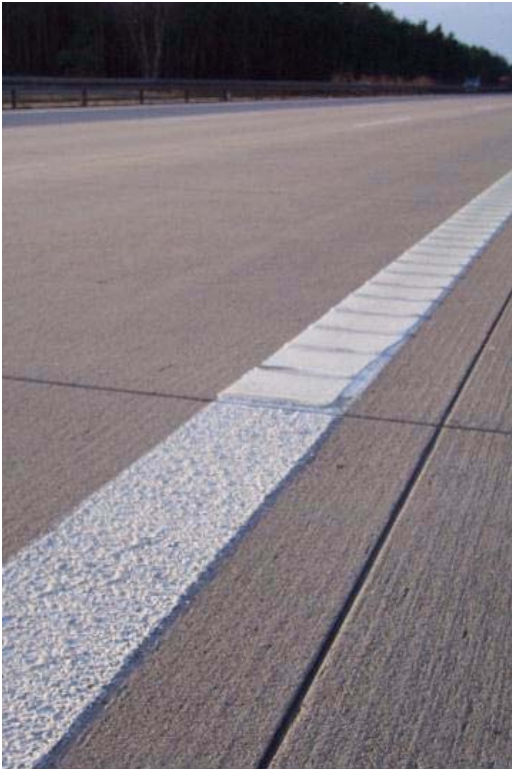
Übergang Randmarkierung KP Agglomerate/ KP 90° Querprofilierung auf der BAB A 2 bei Tag, Richtungsfahrbahn Hannover, km 13,5
