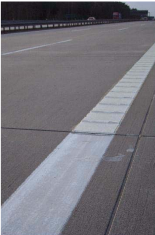
Übergang Randmarkierung Farbe/ KP 90° Querprofilierung auf der BAB A 2 bei Tag, Richtungsfahrbahn Hannover, km 15,3
