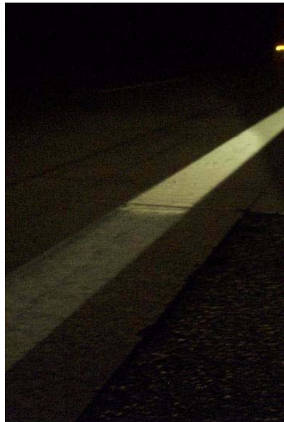
Übergang Randmarkierung Farbe/ KP Agglomerate auf der BAB A 2 bei Nacht, Richtungsfahrbahn Hannover, km 12,5
