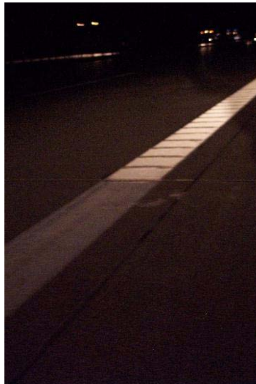
Übergang Randmarkierung Farbe/ KP 90° Querprofilierung auf der BAB A 2 bei Nacht, Richtungsfahrbahn Hannover, km 15,3
