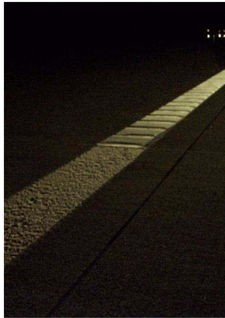
Passage du marquage de bord agglomérats KP / profil transversal KP à 90° sur l'autoroute A2 de nuit, Voie direction Hanovre, km 13,5
