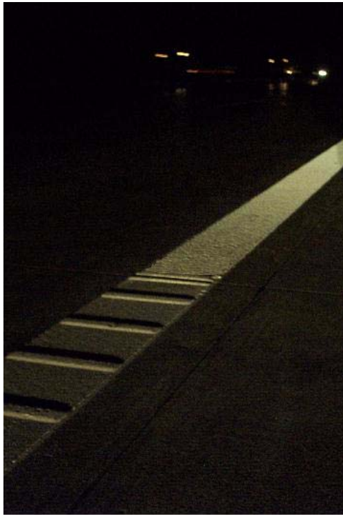
Passage du marquage de bord profil KP / agglomérats KP sur l'autoroute A2 de nuit, Voie direction Hanovre, km 5.0
