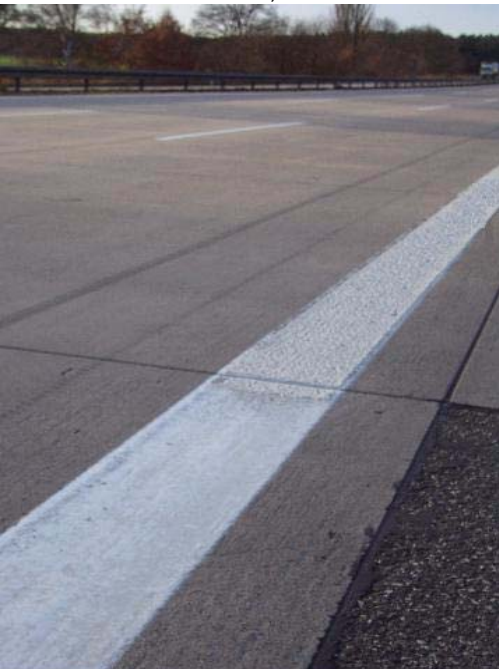
Passage du marquage de bord profil KP / agglomérats KP sur l'autoroute A2 de jour, Voie direction Hanovre, km 5.0
