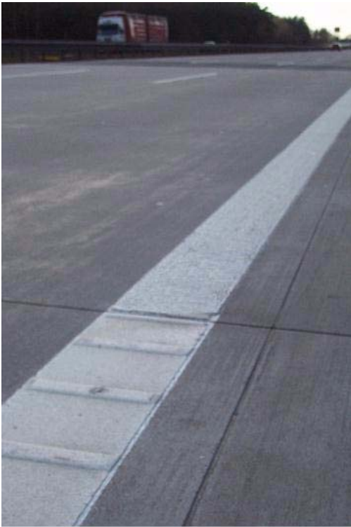
Passage du marquage de bord profil KP / agglomérats KP sur l'autoroute A2 de jour, Voie direction Hanovre, km 5.0
