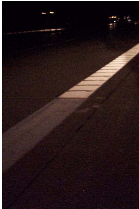
Passage du marquage de bord Peinture / Profil transversal KP à 90° sur l'autoroute A2 de nuit, Voie direction Hanovre, km 15,3
