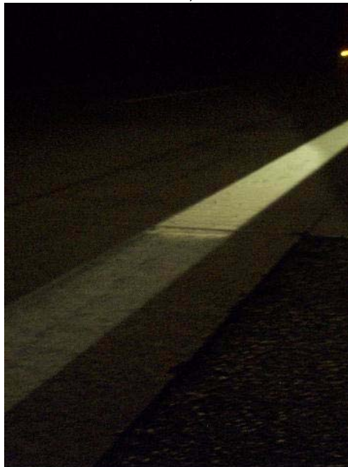
Passage du marquage de bord profil KP / agglomérats KP sur l'autoroute A2 de nuit, Voie direction Hanovre, km 5.0
