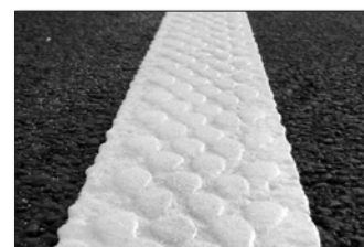
Маркировка MultiDotLine®Plus, нанесение профиля на гладком штрихе за одну рабочую операцию
