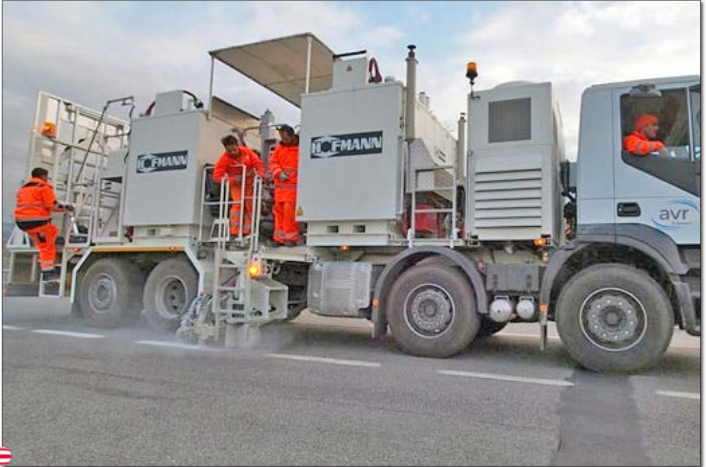
H75-4000P mit drucklosen Behältern (4 x 1000 ltr) für spritzbare Thermoplastiken mit Schneckenpumpe, Markeur beidseitig
