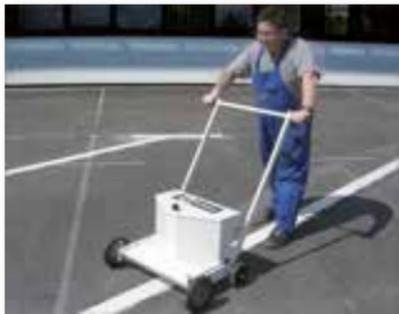
**L'épandeur de billes de verre guidé manuellement est utile partout où l'application mécanique de billes de verre n'est pas possible et où l'application à la main n'est pas rentable ou non autorisée.**
