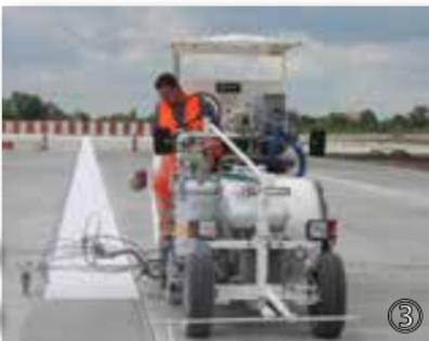
③ H26 bei Airbus in Hamburg / Deutschland ausgerüstet mit 1K-Kaltfarben Airless sowie 2K-Kaltspritzplastiken Airless System M98:2, 460 ltr Druckbehälter sowie 90 cm Breitstrichmarkeur mit 3 Farbpistolen.
