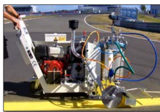
H9-2 Nürburgring à Nürburg, Allemagne
