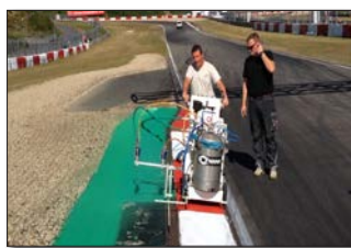
H9-2 Nürburgring à Nürburg, Allemagne
